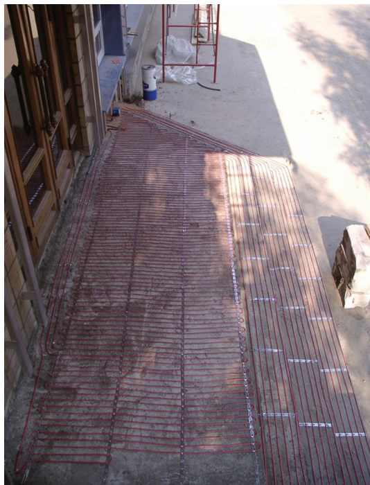
Фото 3. Монтаж системы снеготаяния на крыльце.
