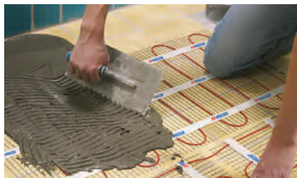
12. Затирка плиточным клеем
