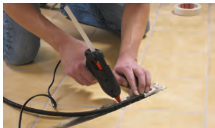
7. Фиксация гофротрубки
