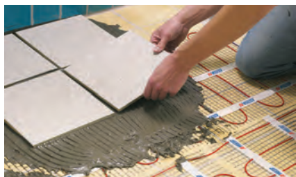
13. Установка плитки*
