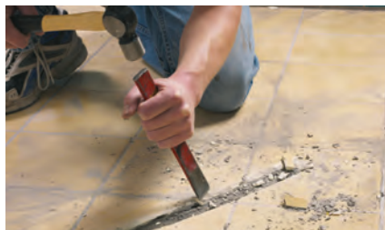
5. Штробление канала и установка гофротрубки для датчика
