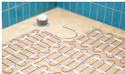
11. Продолжение укладки мата
