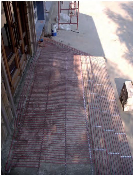
Фото 3. Монтаж системы снеготаяния на крыльце.
